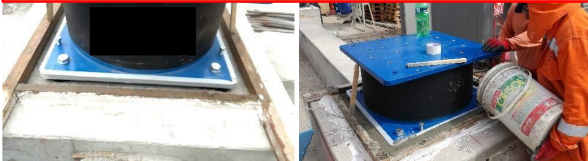
Figura 5.12 “Vertido del grout”
