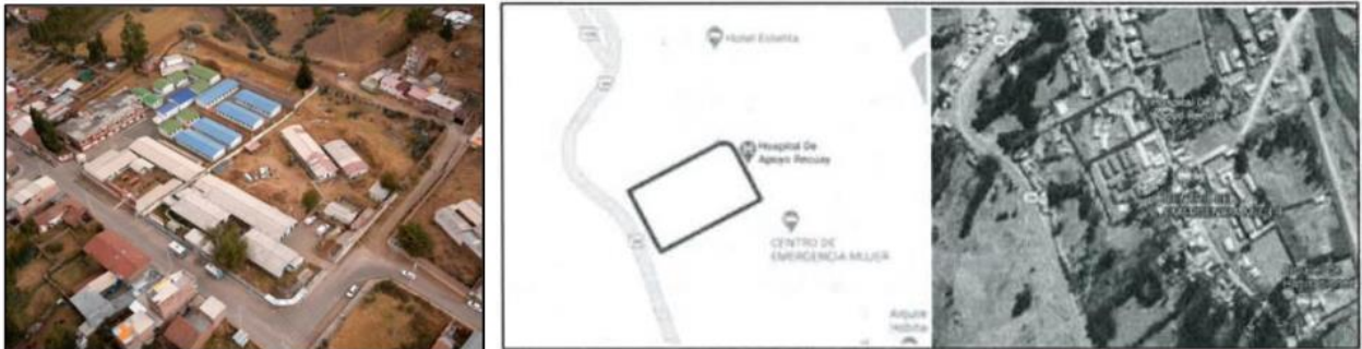
Vista de ubicación general del terreno del Hospital de Apoyo de Recuay.
