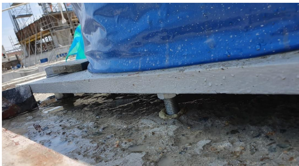
Figura 5.8 “Aislador posicionado sobre espárragos de nivelación de 1/2” con tuerca, previamente anclados al concreto”
