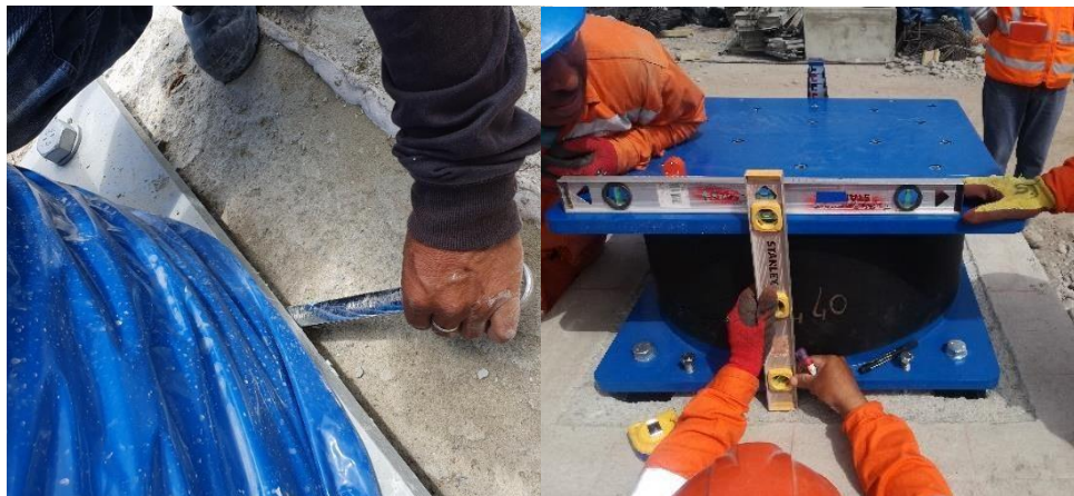
Figura 5.10 “Nivelación de aislador”
