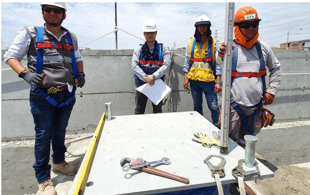
Figura 5.11 “Nivelación de aislador con nivel topográfico o estación total”
