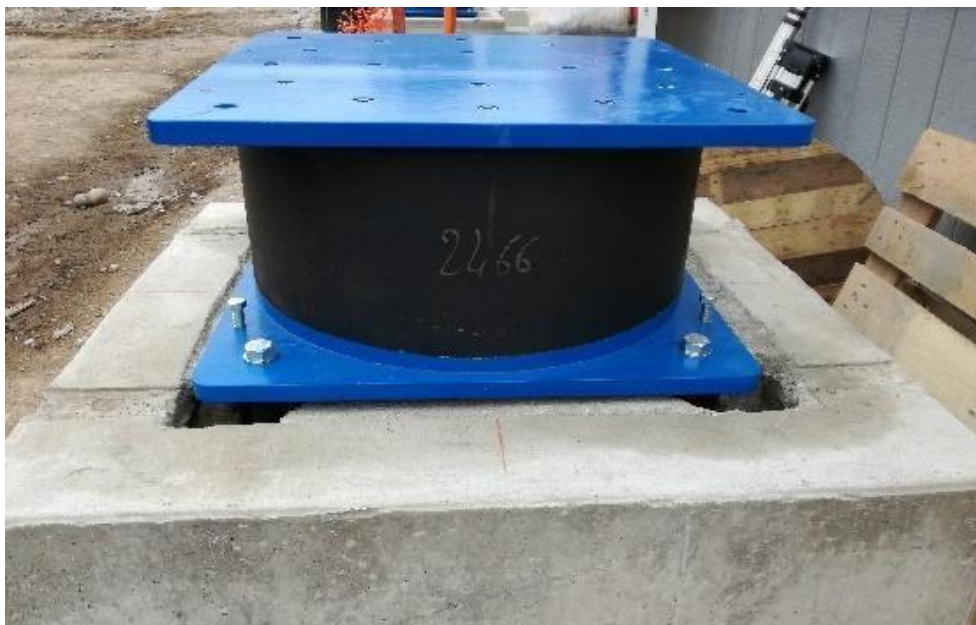
Figura 5.7 “Aislador en posición con los cuatro anclajes inferiores ajustados”
