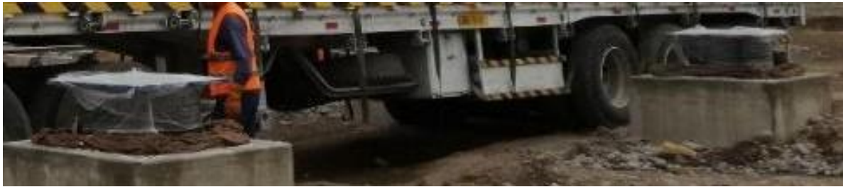
Figura 5.13 “Curado del grout con yutes húmedos”
