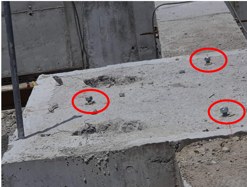
Figura 5.9 “Cuatro espárragos de nivelación anclados al concreto”
