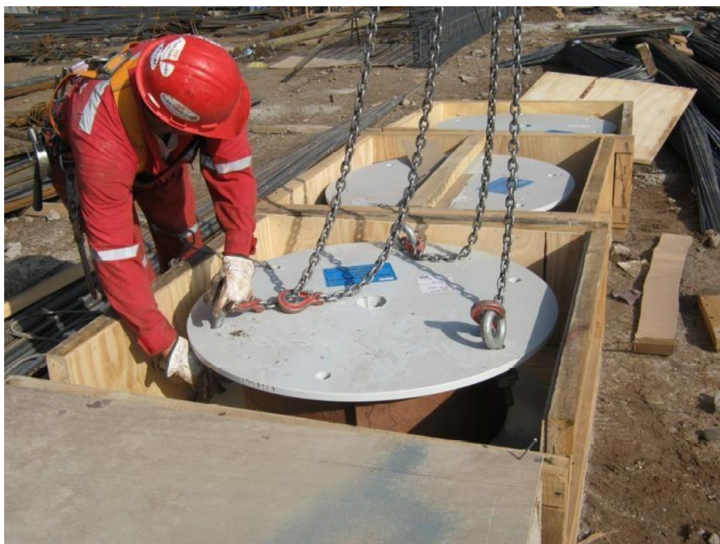
Figura 4.2 “Izado de un dispositivo con grúa”
