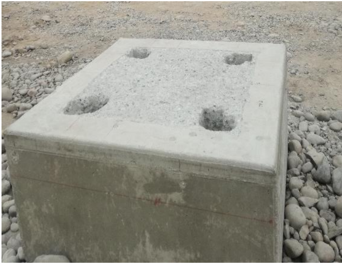
Figura 5.3 “Agujeros para anclajes en pedestal inferior”
