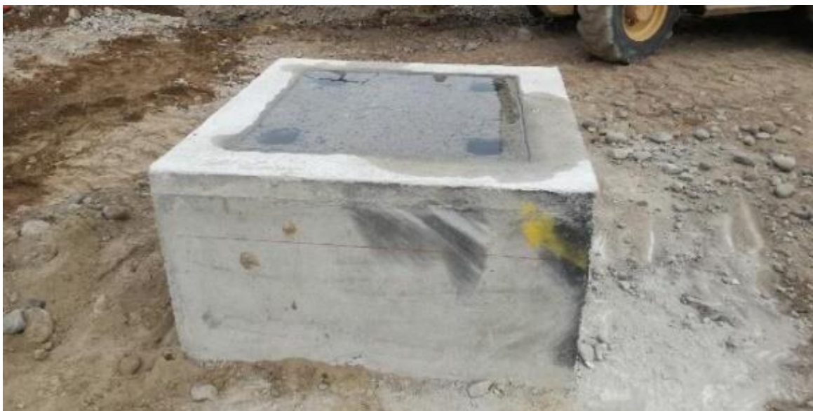
Figura 5.4 “Superficie en la que se colocará el grout debe ser saturada por mínimo 24 horas lo recomendado por el proveedor”
